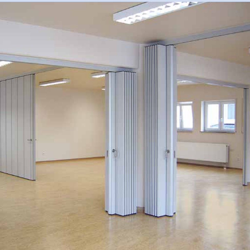
Die Abbildung zeigt den Gemeindesaal einer Kirche. Die kreuzweise angeordneten Faltwandanlagen ermöglichen eine Vielzahl von Varianten der Raumgestaltung.
