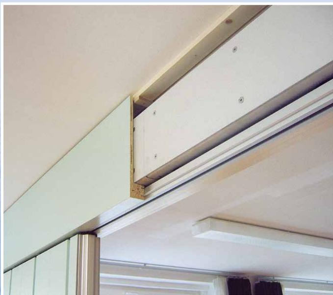
Diese nimmt mit ihrem auf zwei Stahlstützen befestigten Profilrohrträger sämtliche Last der Faltwand auf.
